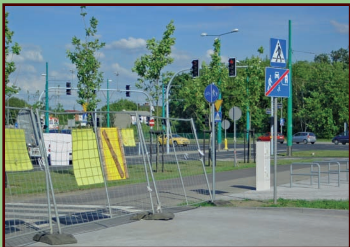
Z powodu braku decyzji urzędników parking przy cmentarzu junikowskim nadal nieczynny mimo zakończenia budowy.
