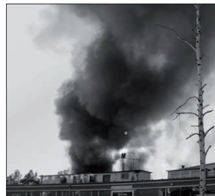
Ogromny słup dymu towarzyszył pożarowi hali z nieczynną ścianką wsporniczkową przy ul. Smoluchowskiego
